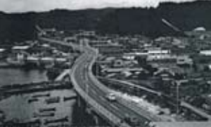
1972年開通の国道45号線は壊滅した Coastal Hwy45 opened in 1972, destroyed 3.11.2011
